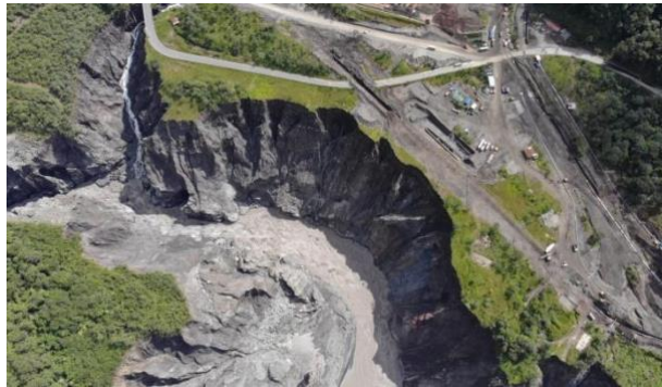
Pie de foto: Avance progresivo de la erosión del río Quijos
